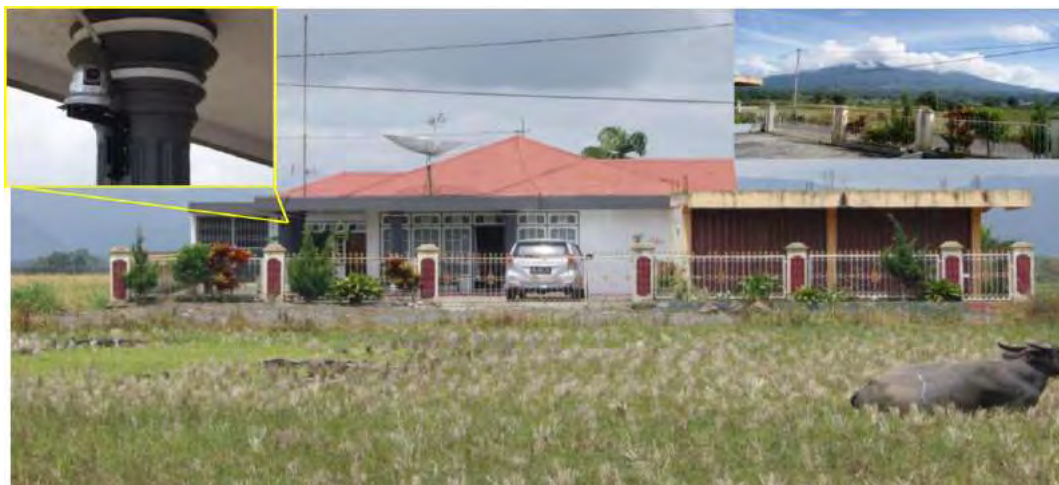
Gambar 4.14. Kamera CCTV Pemantauan Gunung Marapi, Jorong Cangkiang, Nagari BatuTaba, Kecamatan Empat Angkat Candung, di Rumah Masyarakat Atas Nama Indarmawan, Koordinat Lokasi 0,314275 LS dan 100,4184. Kamera yang Dipasang di Lokasi Bertipe Network (IP) Camera , Panasonic BB-HCM581CE, 42x Zoom (21× Optical & 2× Digital) Kamera Menghadap ke Tenggara
